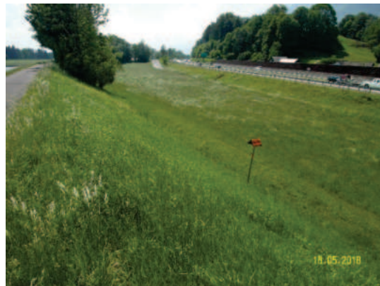
Abbildung 4: Übersicht vom Rheindamm, Blick nach Süden
