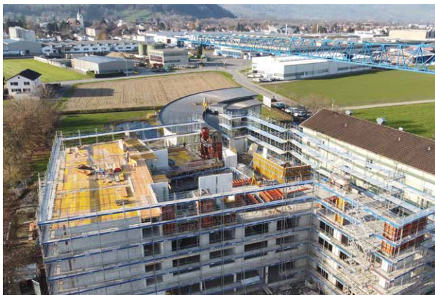
1. Etappe: Ausbau 3. OG
