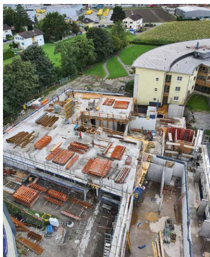
1. Etappe: Erstellung EG – Luftaufnahme
