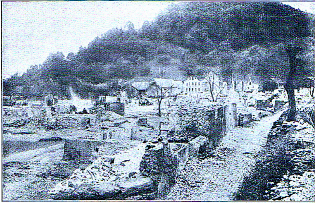
Ruinen vom Oberdorf und Gemeindehaus nach dem Brand.
