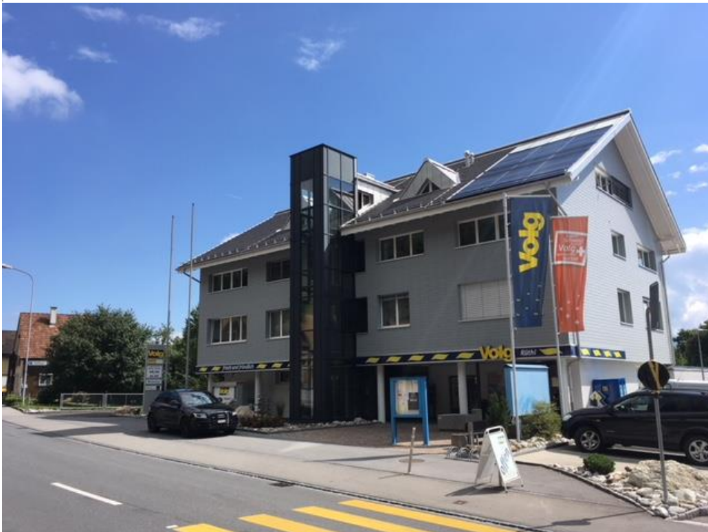
Das Rütli Rathaus erstrahlt nach der Totalsanierung in neuem Glanz.
